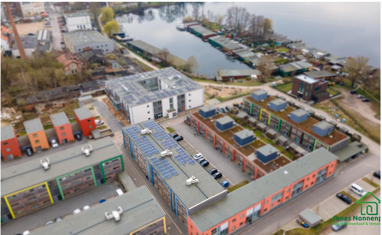
Ansicht nach Südwesten
