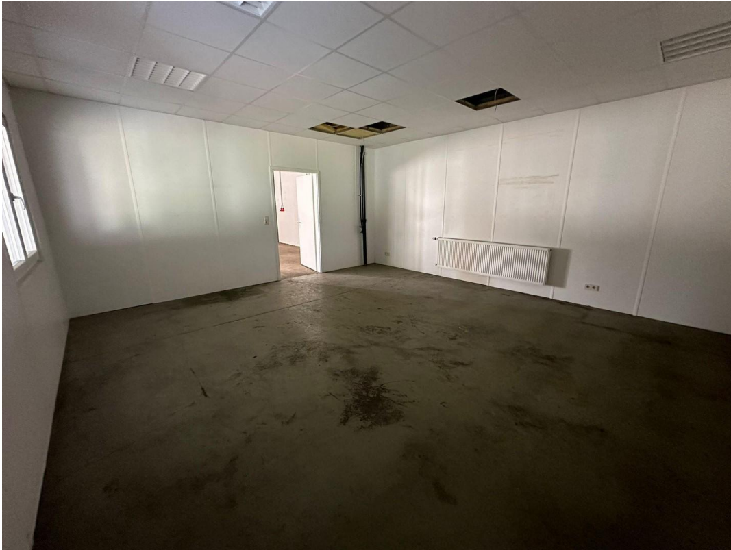
Büro im 2 OG.
