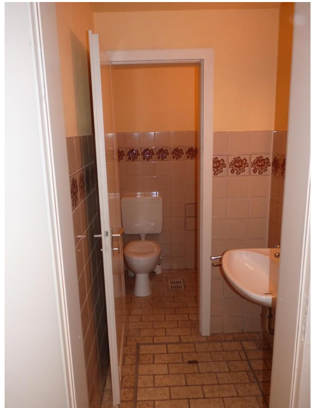
Ladenlokal Sanitär Damen
