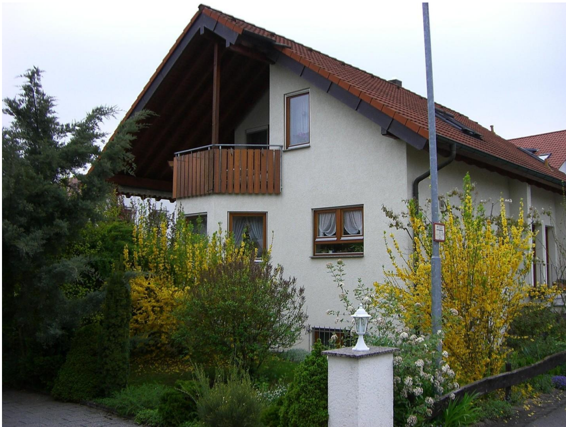
Ansicht von der Waldseite
