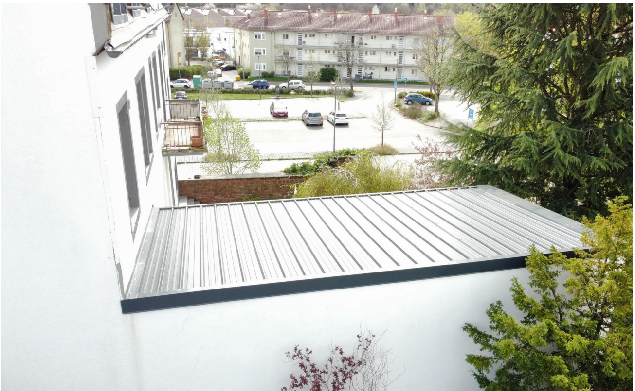
Neues Dach Anbau
