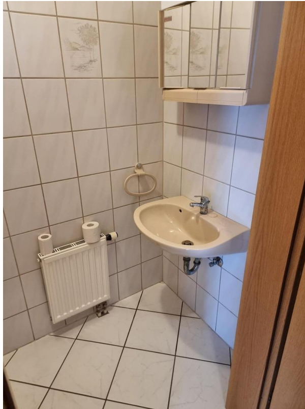
Personal, Umkleide, Waschraum, R4
