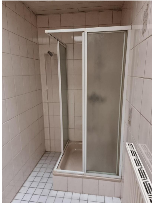
Personal, Umkleide, Waschraum, R4
