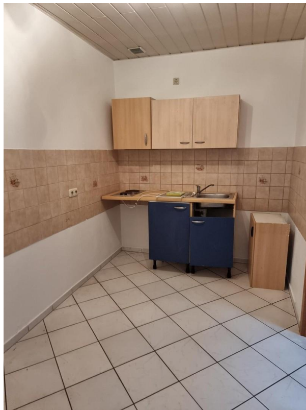
Personal, Umkleide, Waschraum, R4
