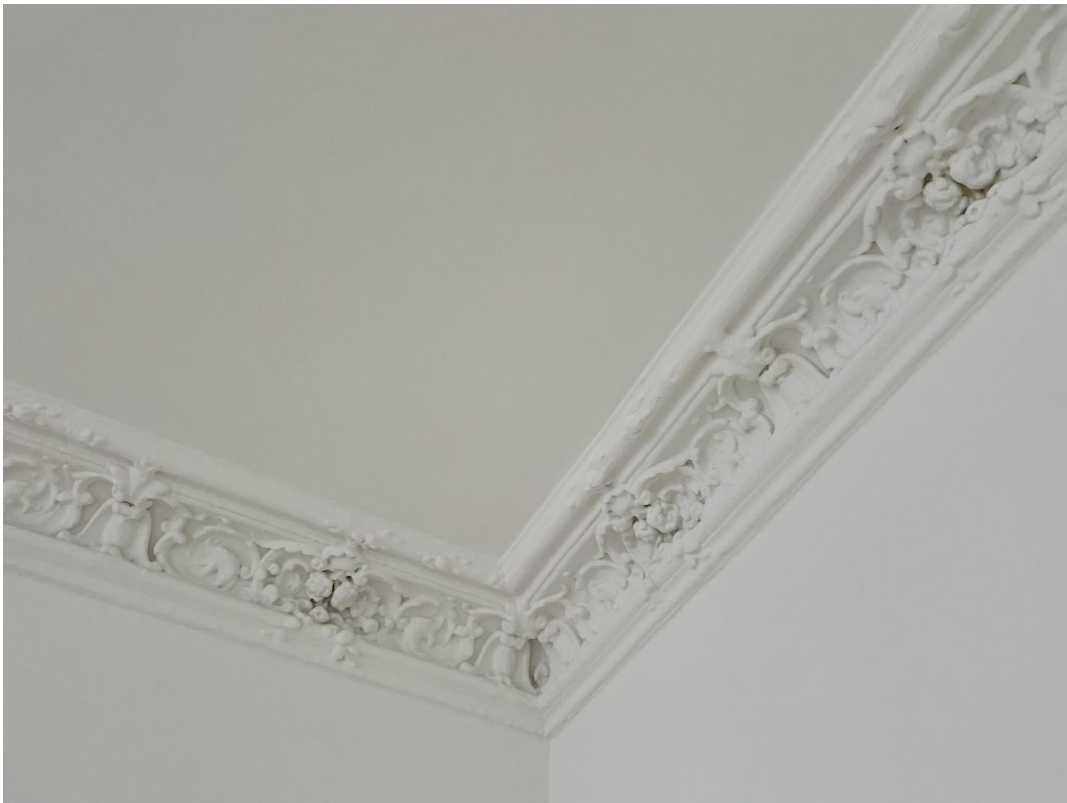
Stuckdecke im Wohnzimmer
