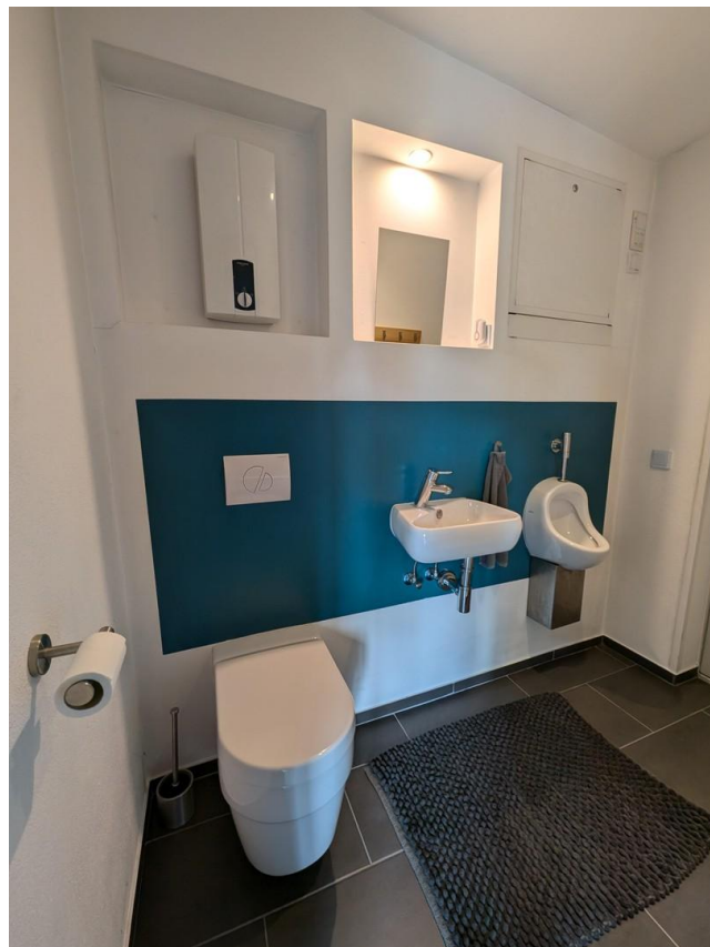
Bad im Saunabereich
