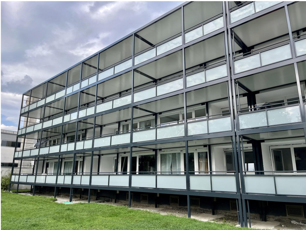
Neue Fassade + Stahlbalkone
