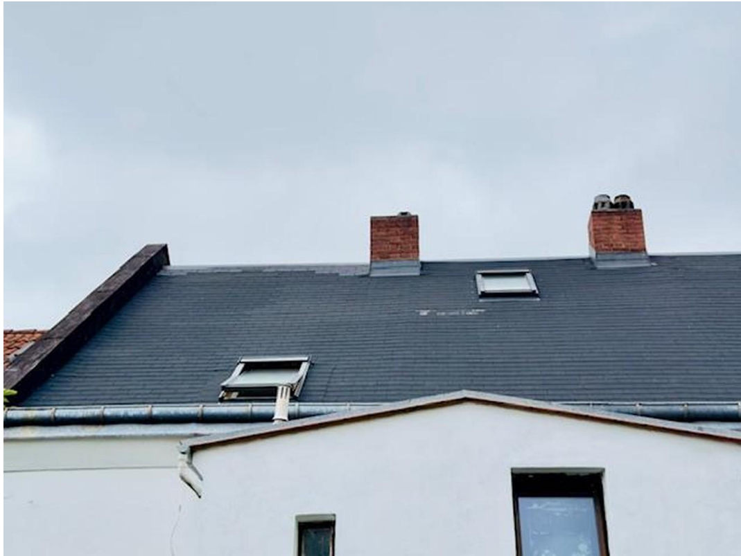
Eine Dachseite erneuert
