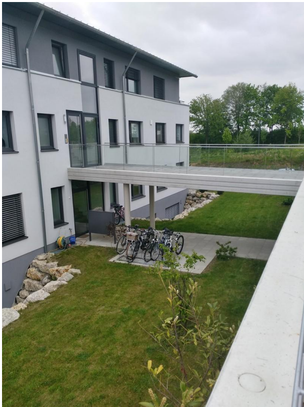
Blick auf Brücke
