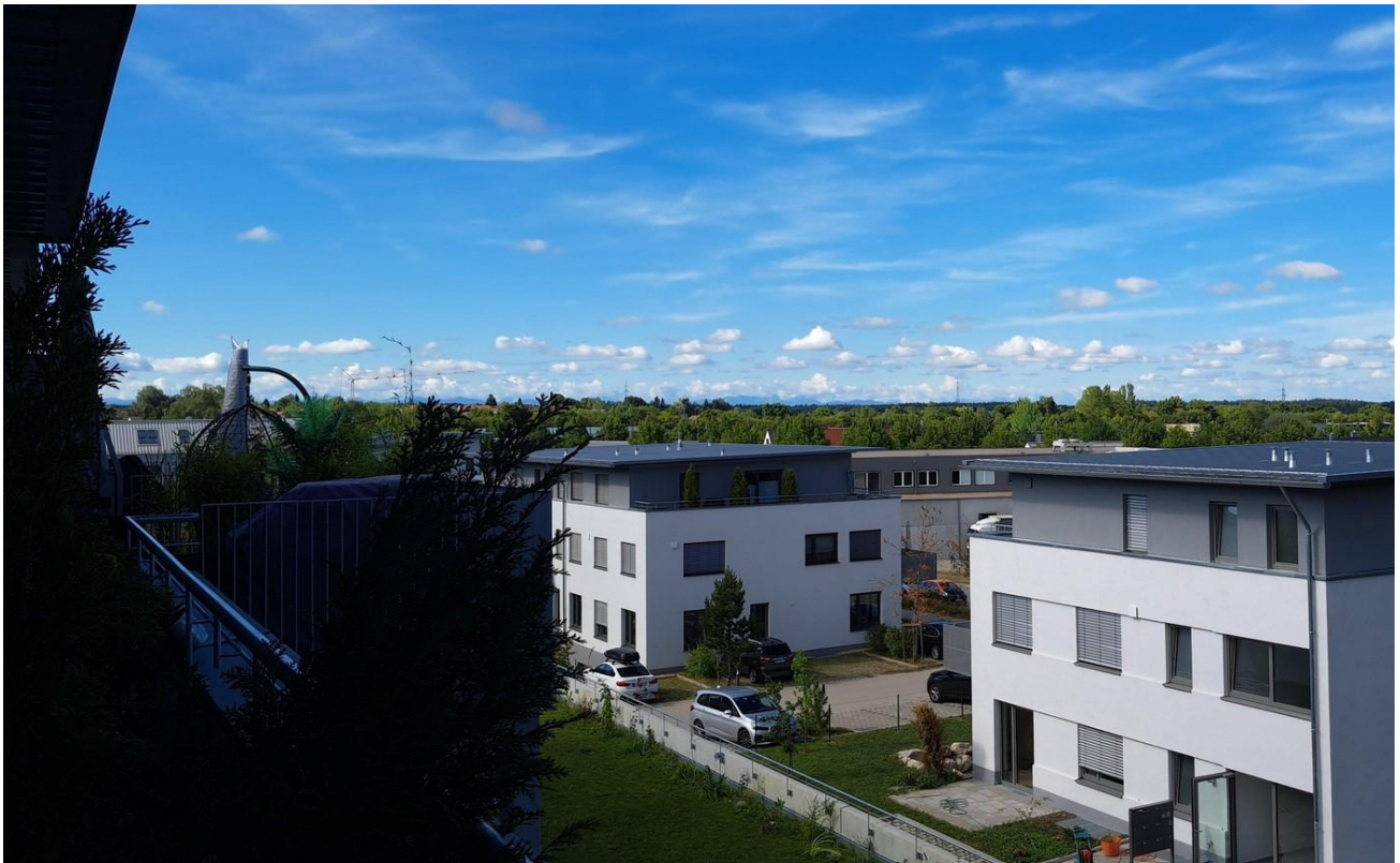
Blick auf Gebäude links
