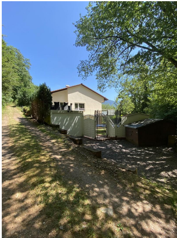
Blick hinter das Haus
