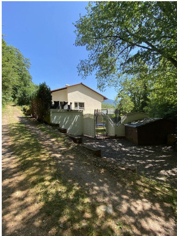
Blick hinter das Haus
