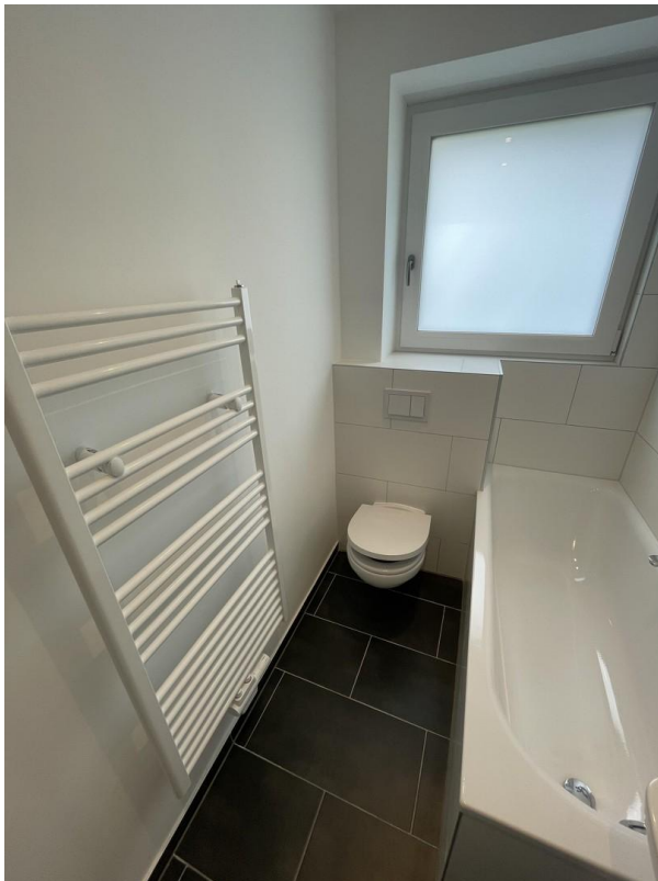
Heizkörper und Toilette
