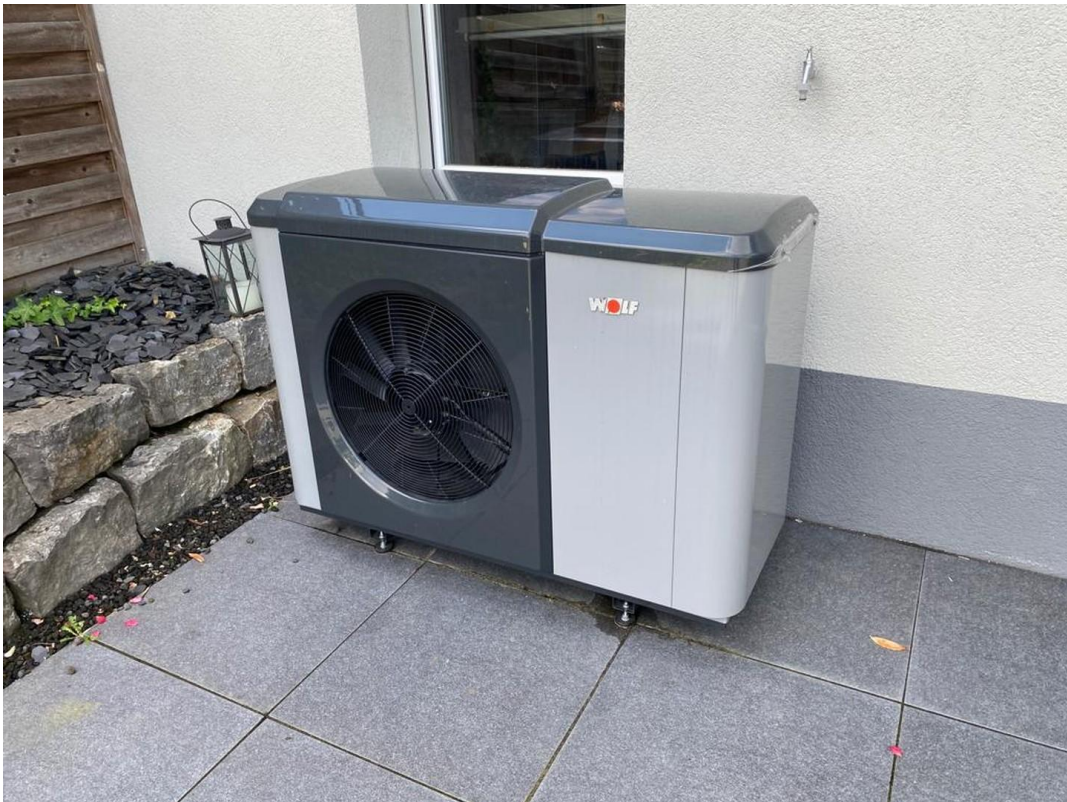
Wärmepumpe
