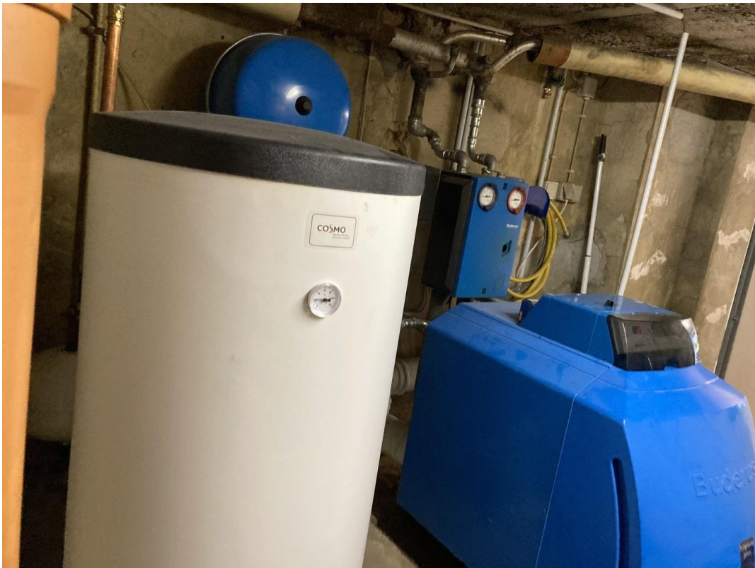
Warmwasserspeicher neu
