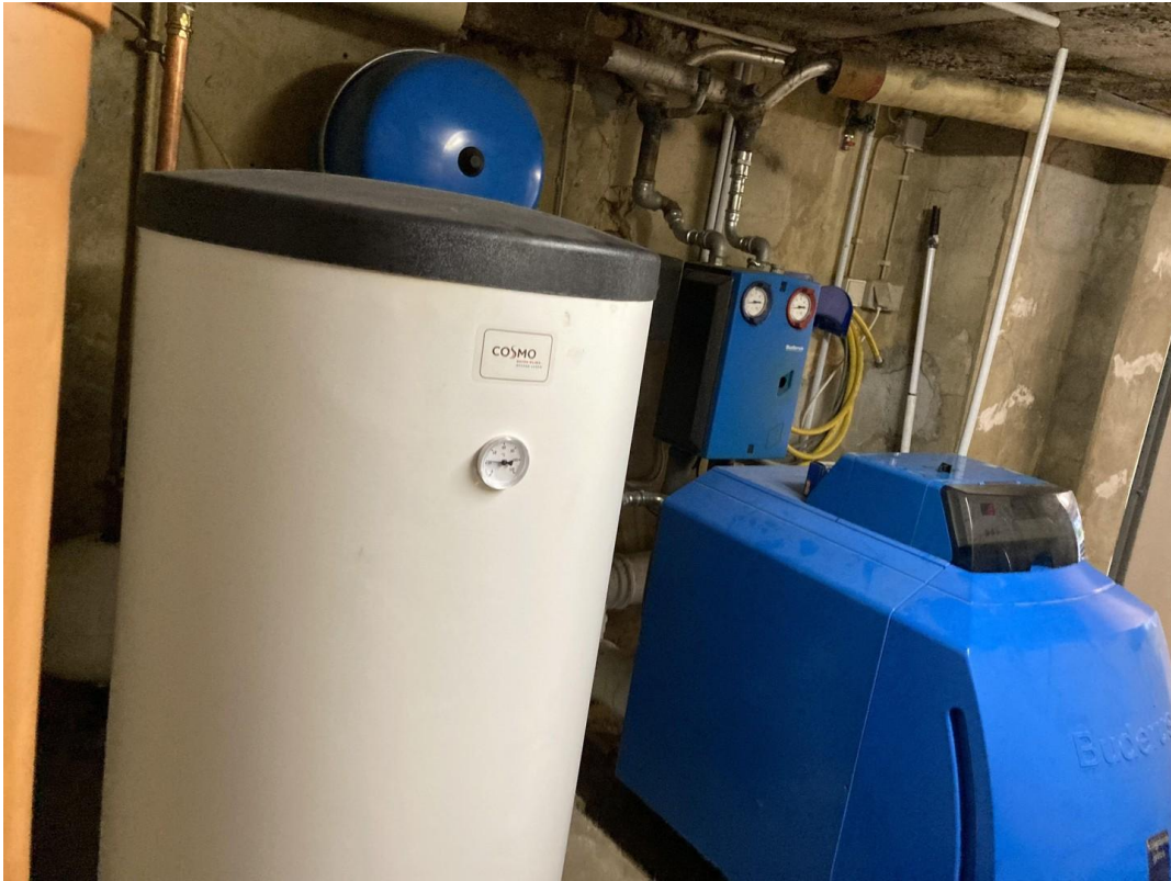
Warmwasserspeicher neu
