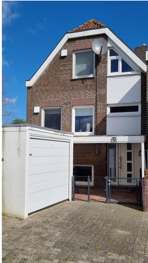
Hausansicht und Garage
