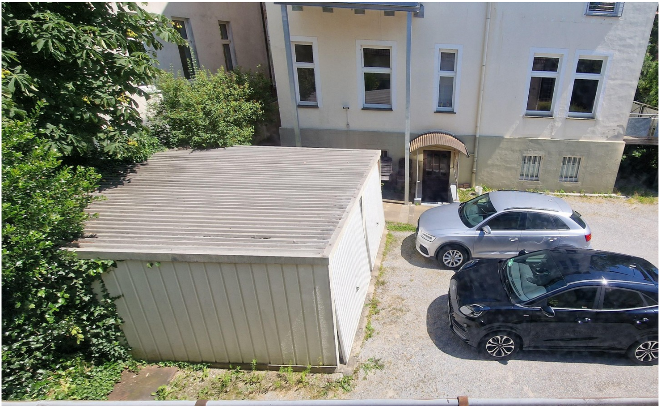
Rückseite, Hof + Kellereingang
