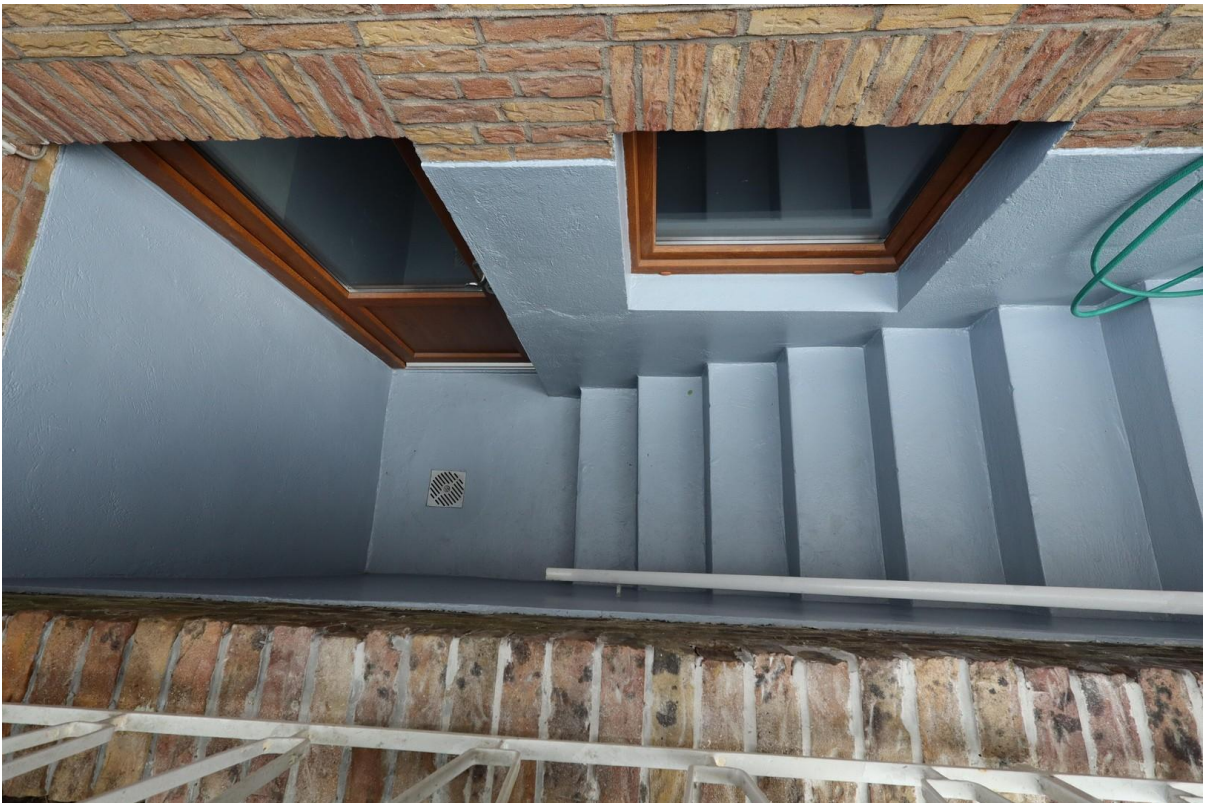
Treppenaufgang vom Keller
