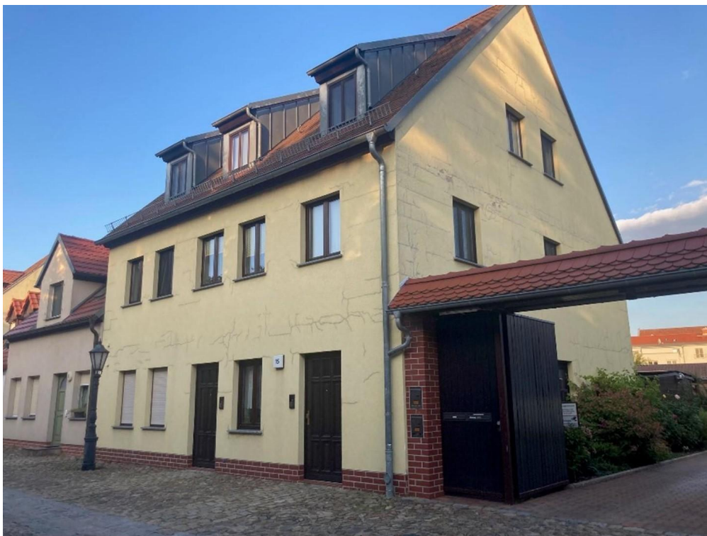
Blick von der Straße
