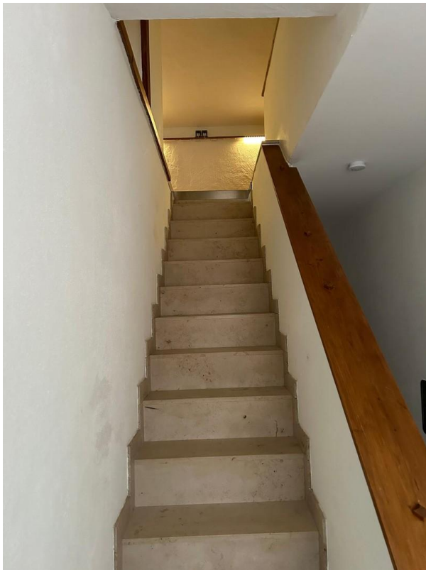
Treppenaufgang zum (DG)
