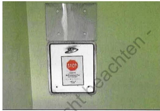
Müllabwurfschacht auf jedem Geschoss
