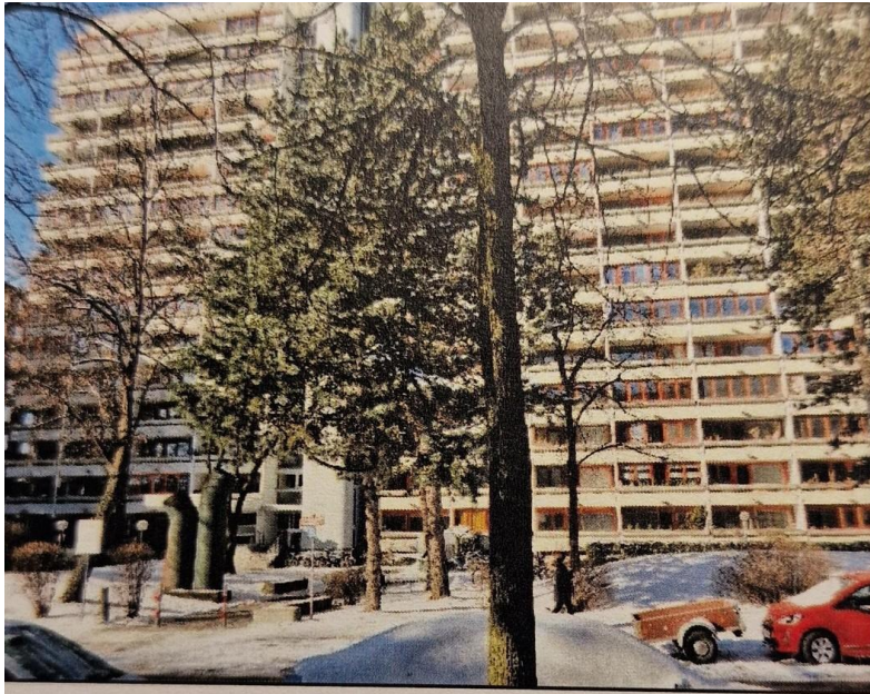
Blick von der Hauzenberger Straße auf das Hochhaus Hausnummer 20 (Ostansicht)
