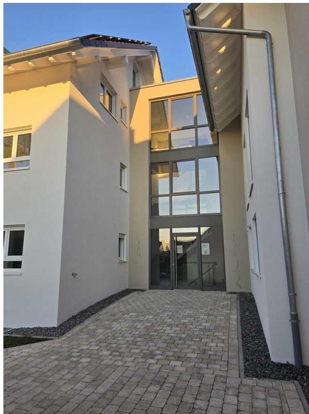
Eingang Haus (oben links)
