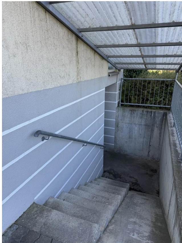
Kellereingang mit Fahrradrampe
