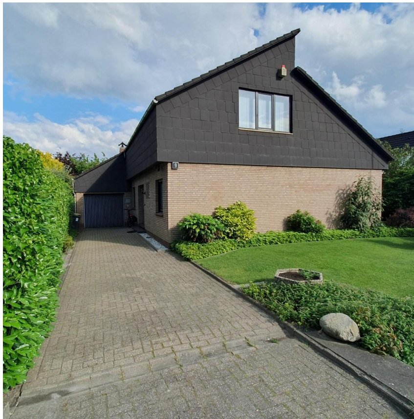
02 Hausansicht NW Straße
