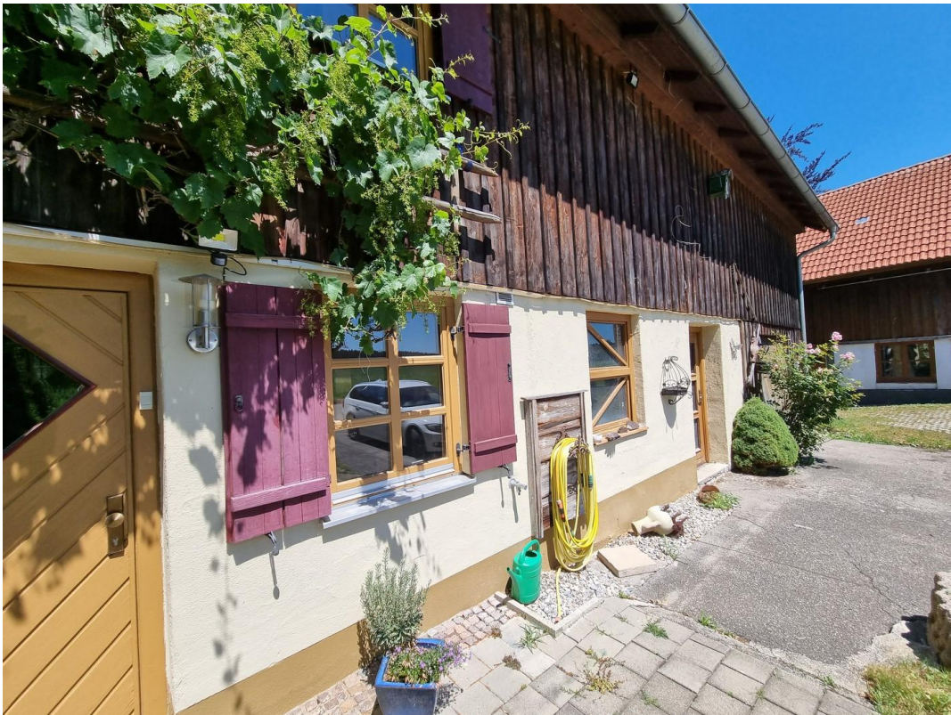
Wasseranschluss und Strom
