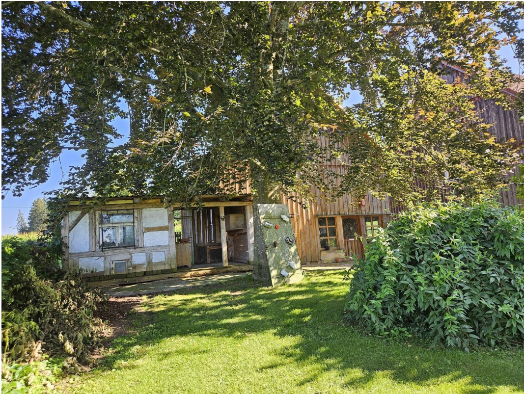
Hühnerstall und Nebengebäude
