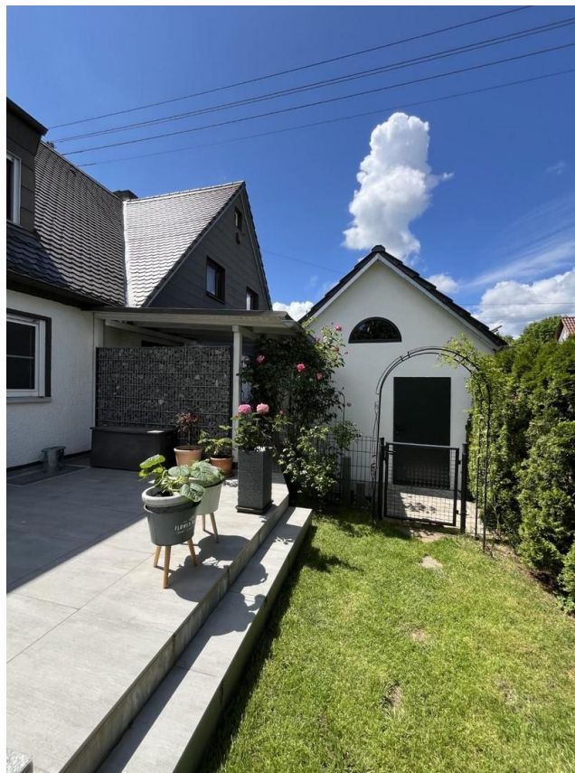
Blick auf Garage Hinterseite
