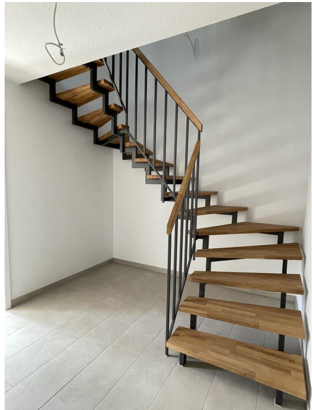
Treppe zum UG mit Flur
