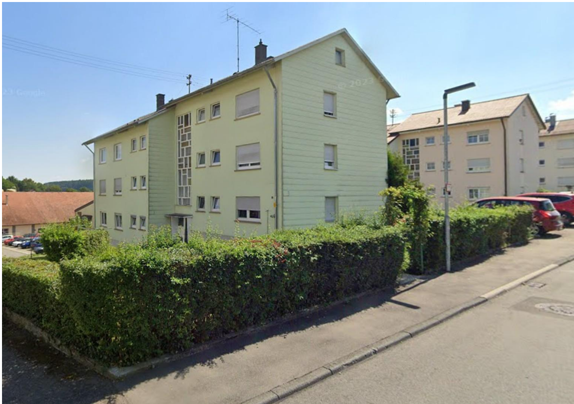
Außenansicht mit Stellplatz
