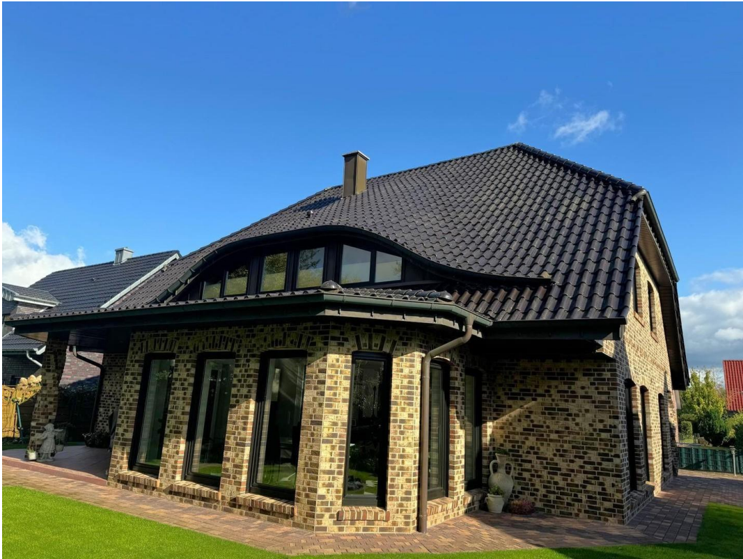
Wintergarten von außen
