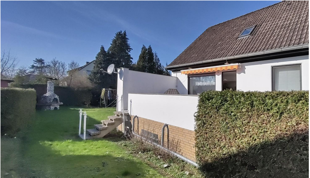
Südseite mit Terrasse
