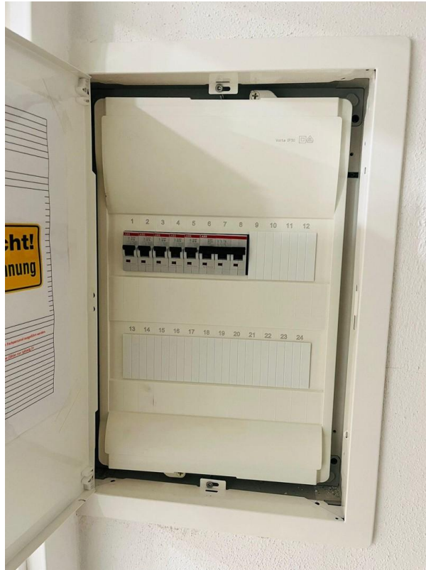
Neuer Sicherungskasten
