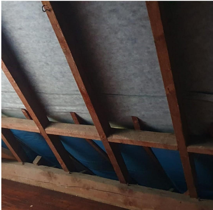
Dach mit Dämmung im 1.OG
