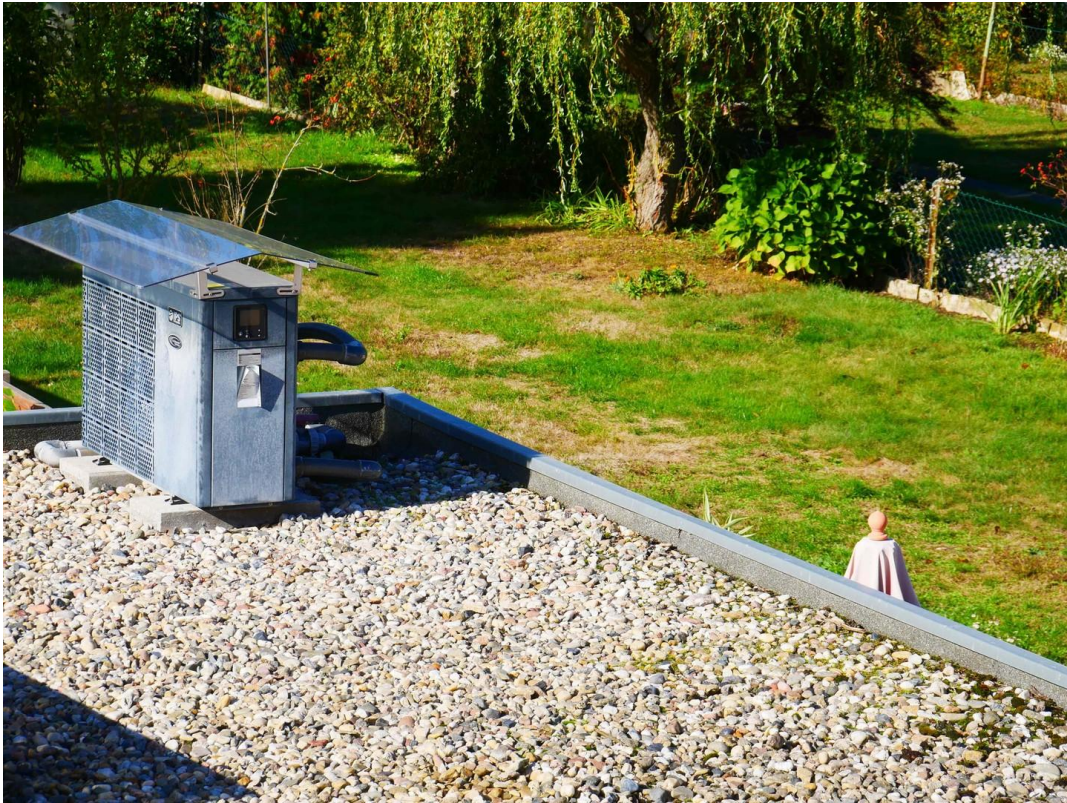
Wärmepumpe
