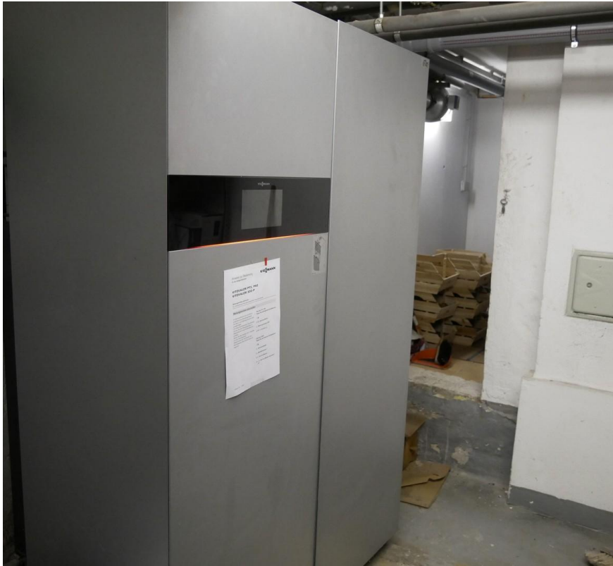
Brennstoffzelle Keller
