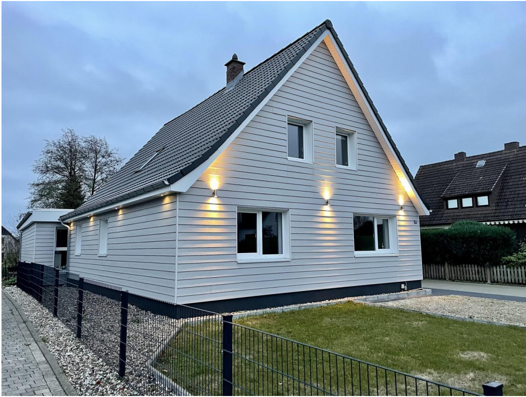
Vord. Haus, Anbau zum Garten
