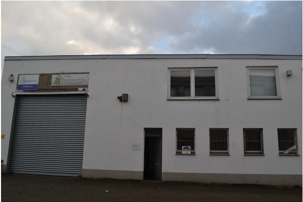
Lager vom Außen
