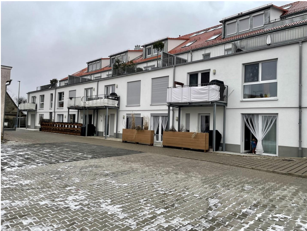
Blick auf die Wohneinheit West
