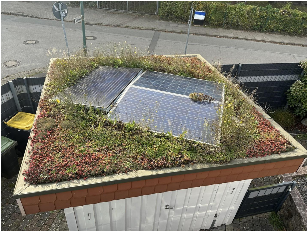
Gründach mit PV-Anlage
