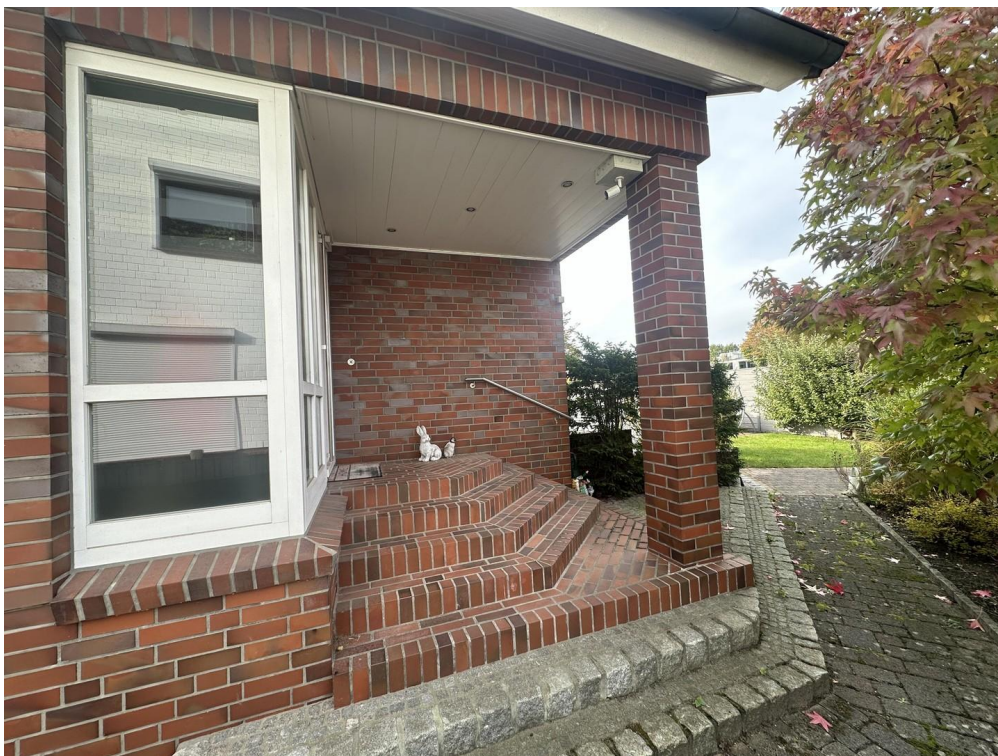
Eingangsbereich mit Treppe
