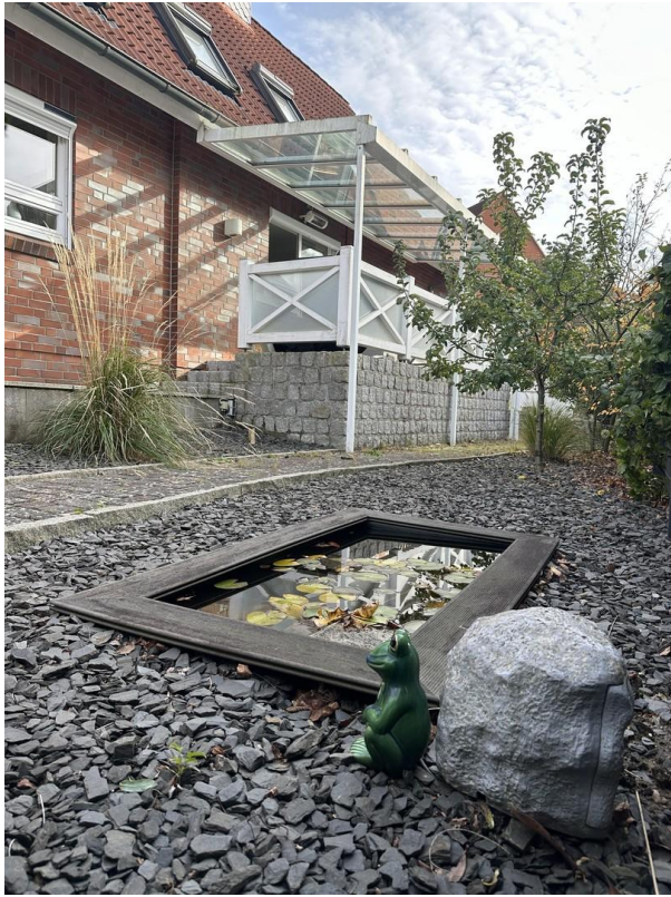
Sonnenterrasse mit Glasvordach
