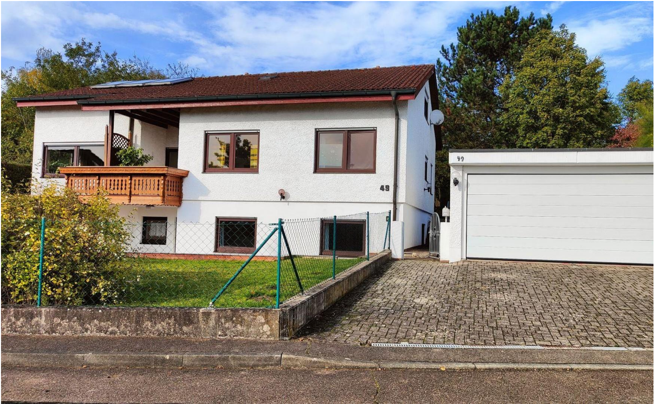
Aussenansicht von der Strasse
