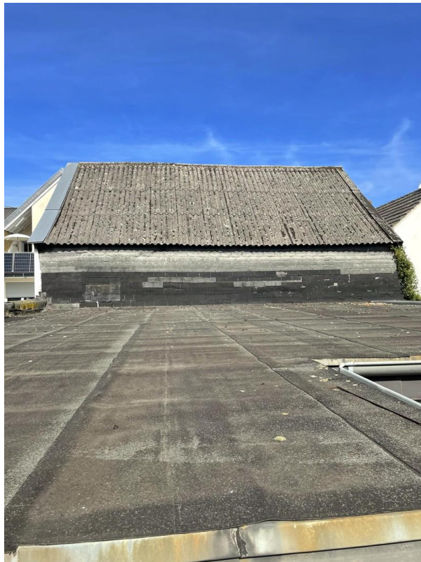
Scheune und Hallendach
