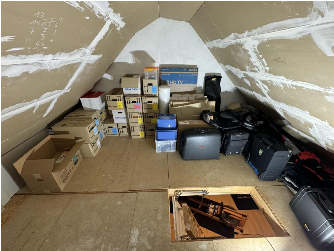
isolierter Stauraum (Speicher)
