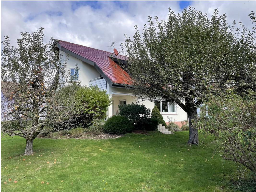
Süd-/ Westfassade - Garten
