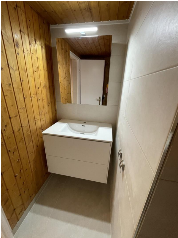
Sauna / Bad UG
