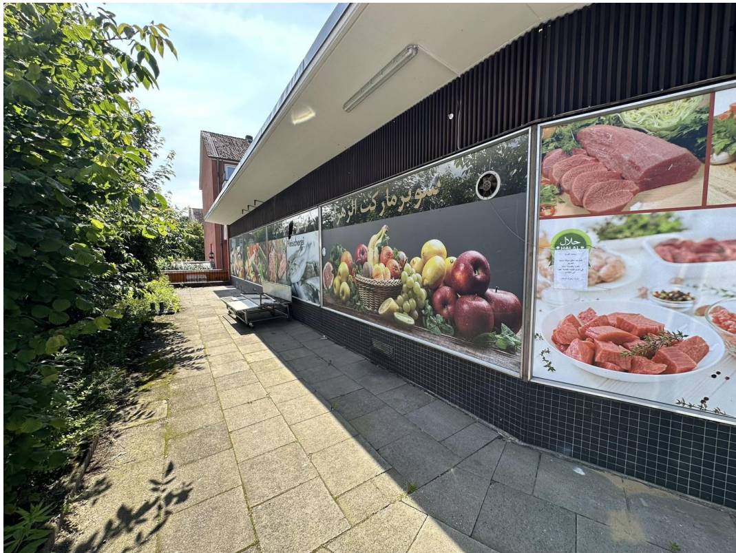
Seitenansicht - ehem. Zustand
