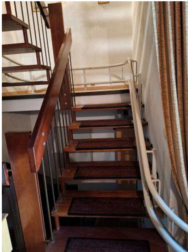
Treppenhaus mit Treppenlift
