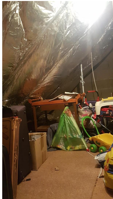
Dachboden Isoliert ca 33qm
