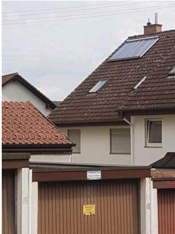
Garage und Solar
