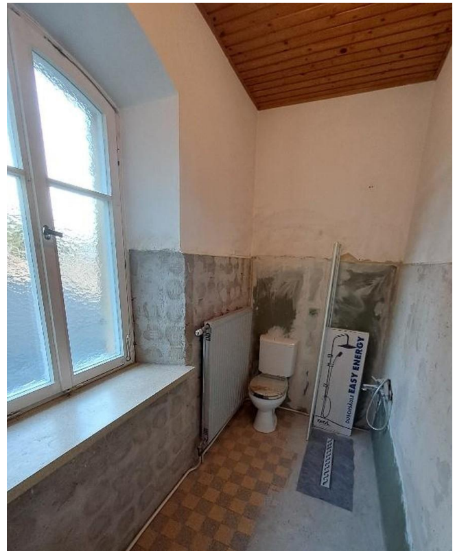
Bad EG, WC, ebenerd. Dusche
