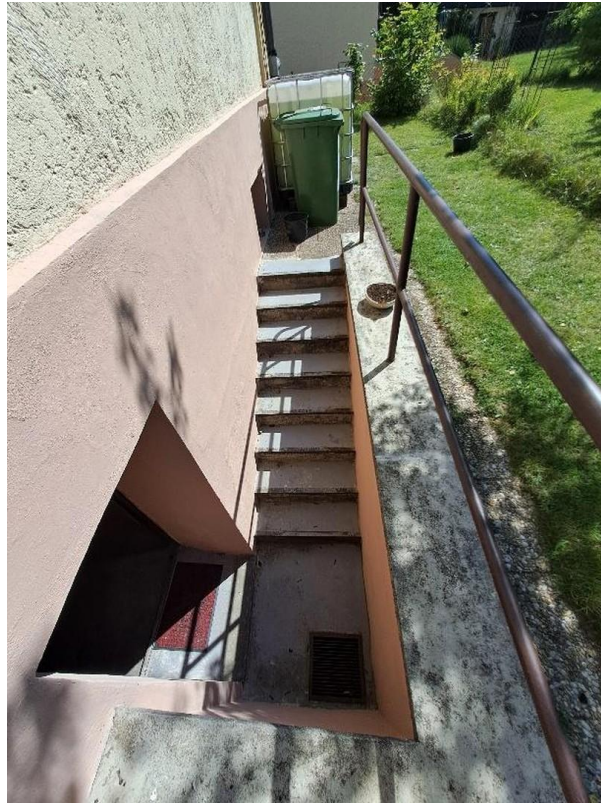
Treppe zu Werkstatt u. Heizung
