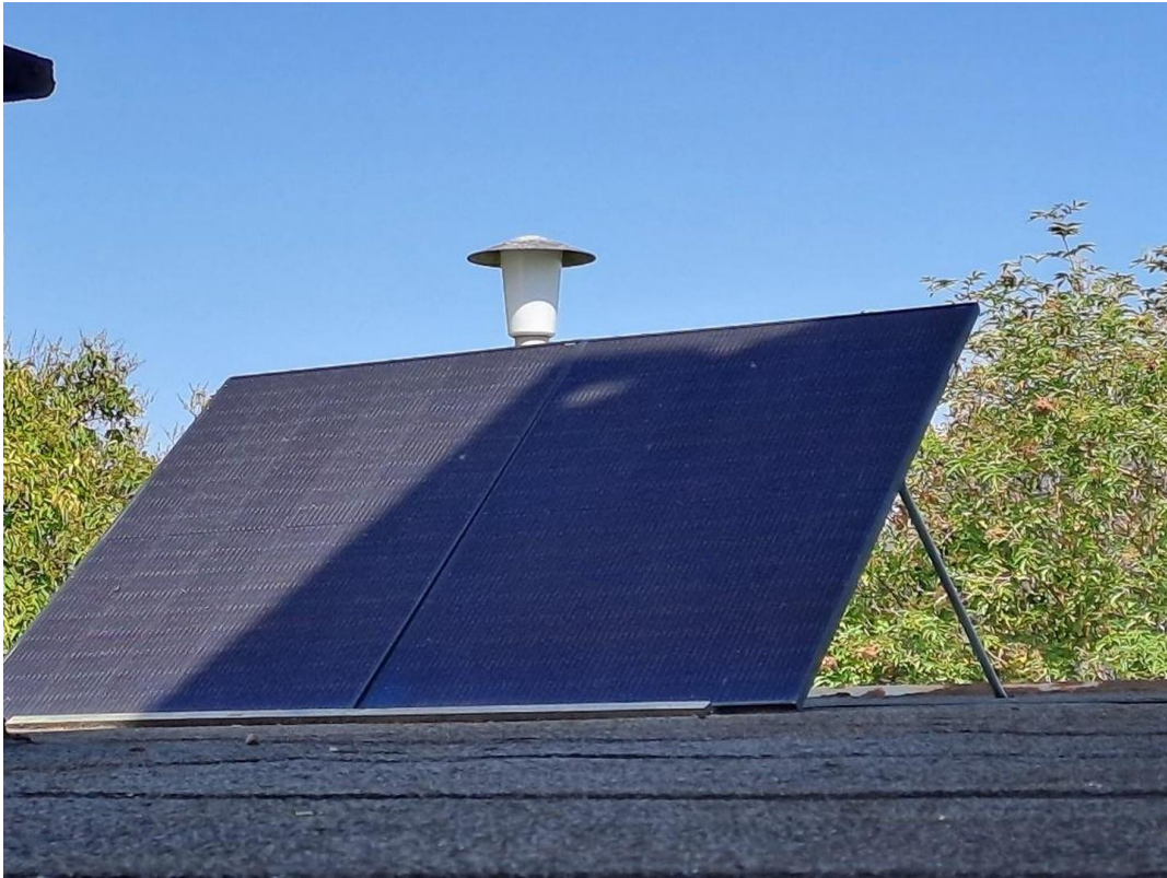
Balkonkraftwerk 800 W
