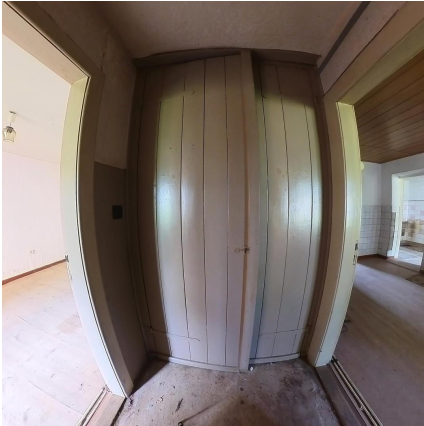
Zwischen SZ2 & Küche
