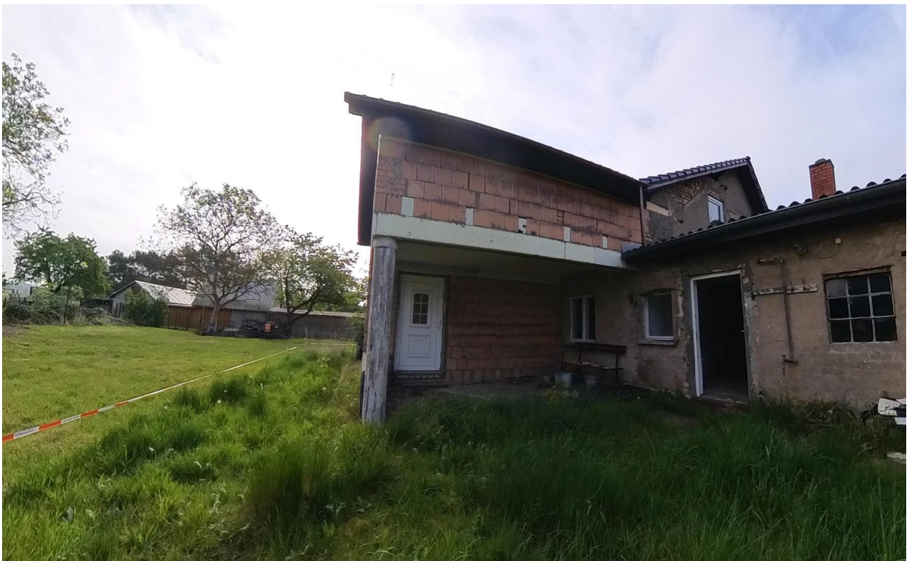
Hof Eingang EG rechts
