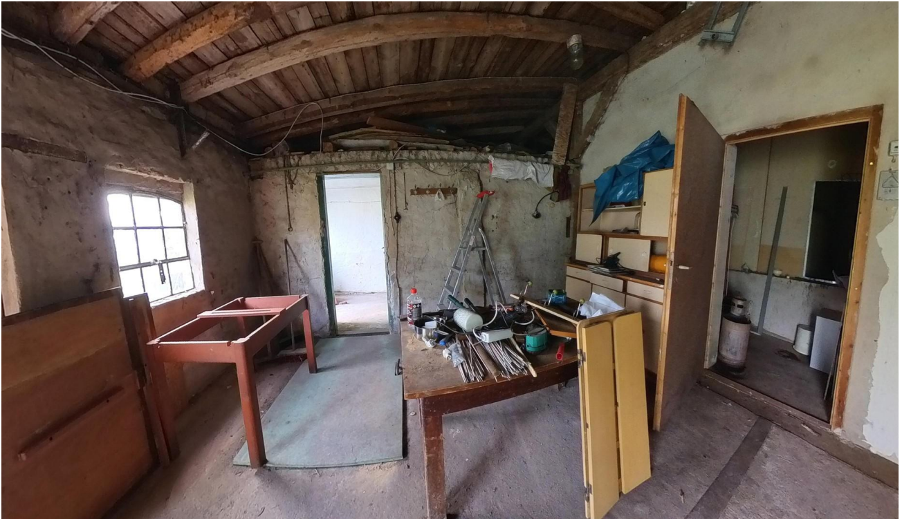
Anbau zum Haus & Heizungsraum
