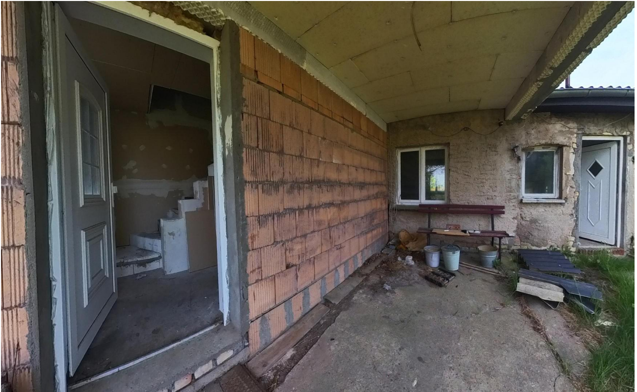
Eingang DG (l) & EG (r)
