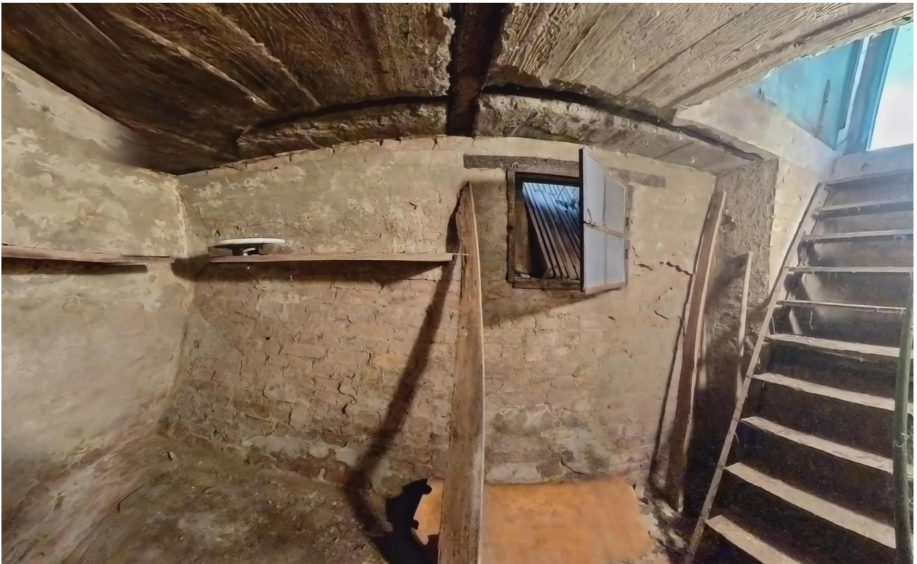
Keller im Anbau
