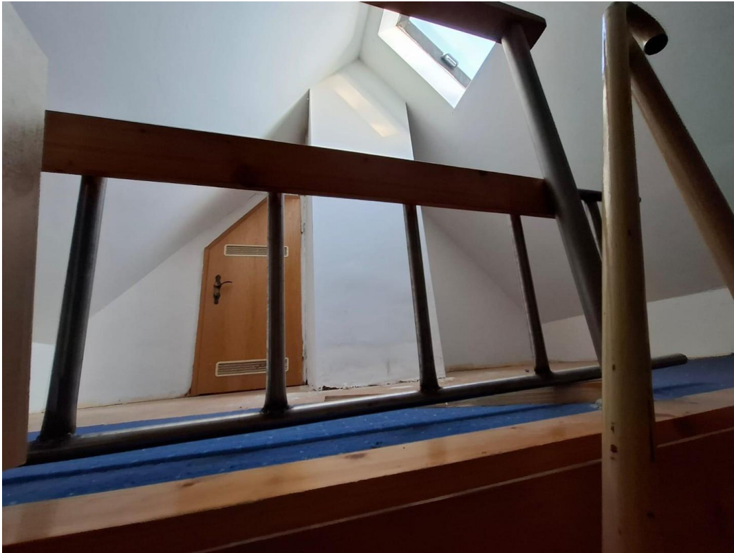
Dachboden linke Seite
