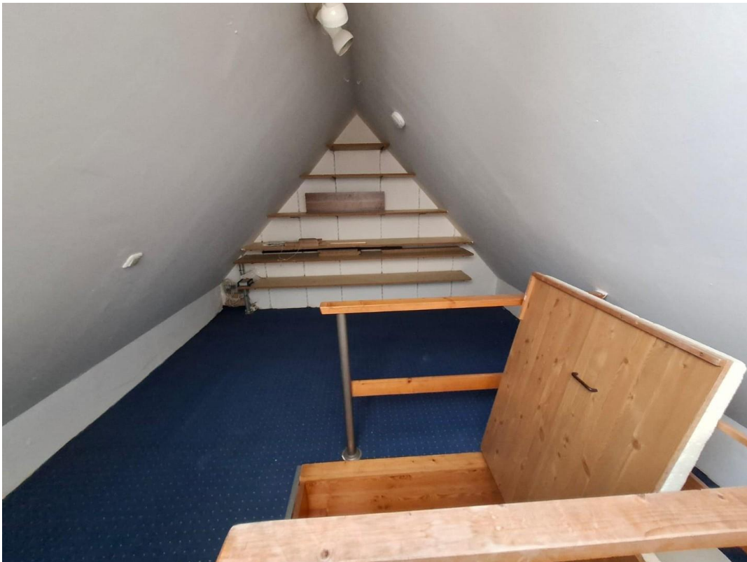
Dachboden rechte Seite
