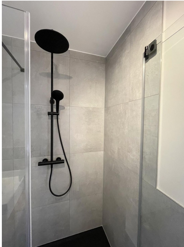
Dusche m. Pendelglastür
