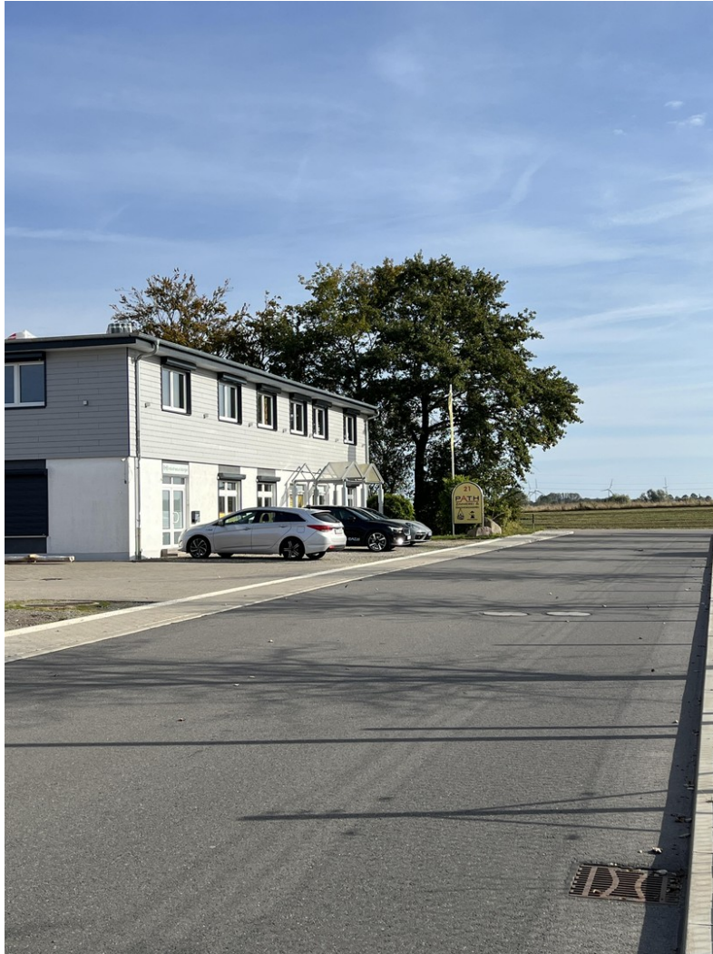
Straße: Am Voßberg,Zuwegung
