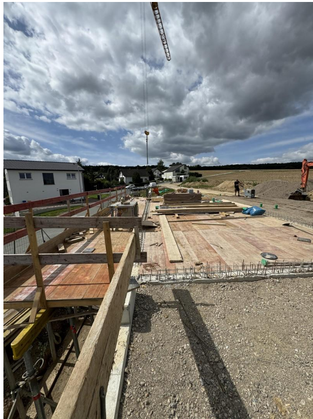
Das wird eine Bodenplatte
