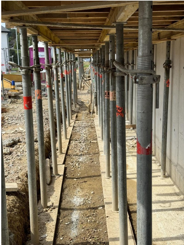
Überstand über den Parkplätzen
