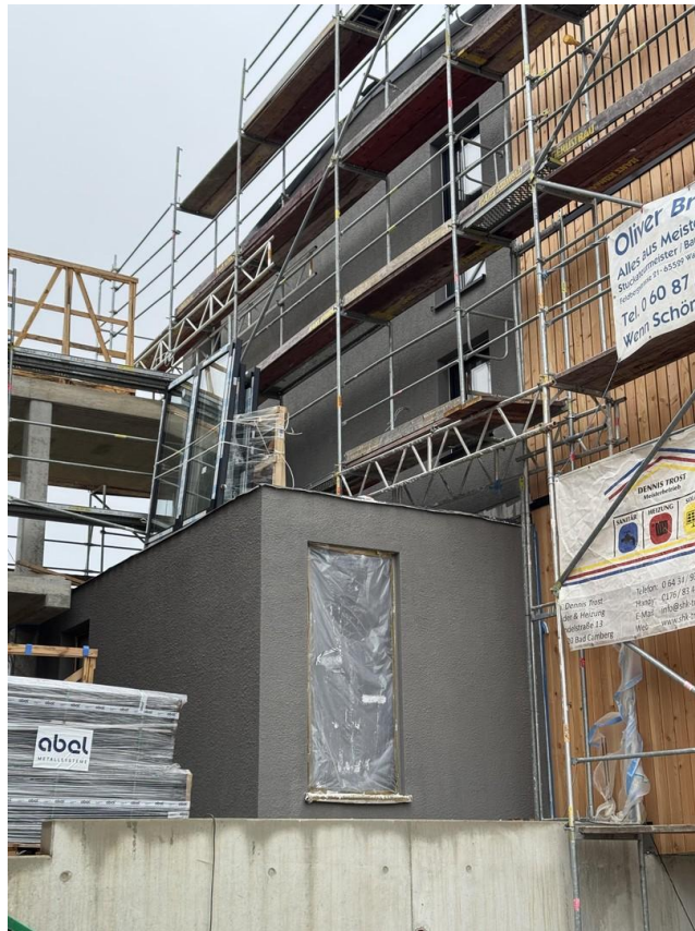
Putz Haus D ist fertig
