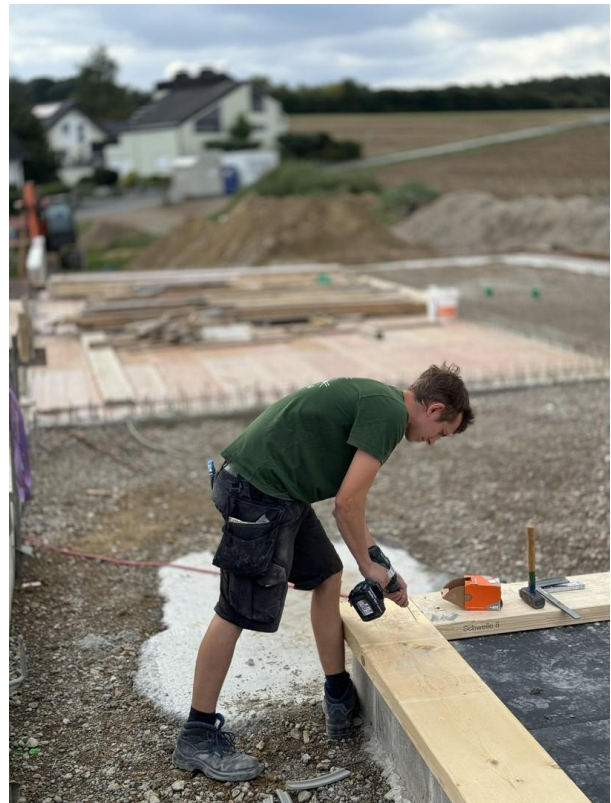
Die Schwellen werden gelegt
