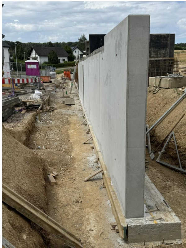
Stützwand mit Fundament
