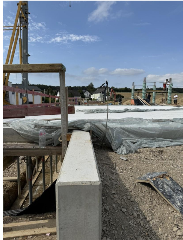
die erste Stützwand steht
