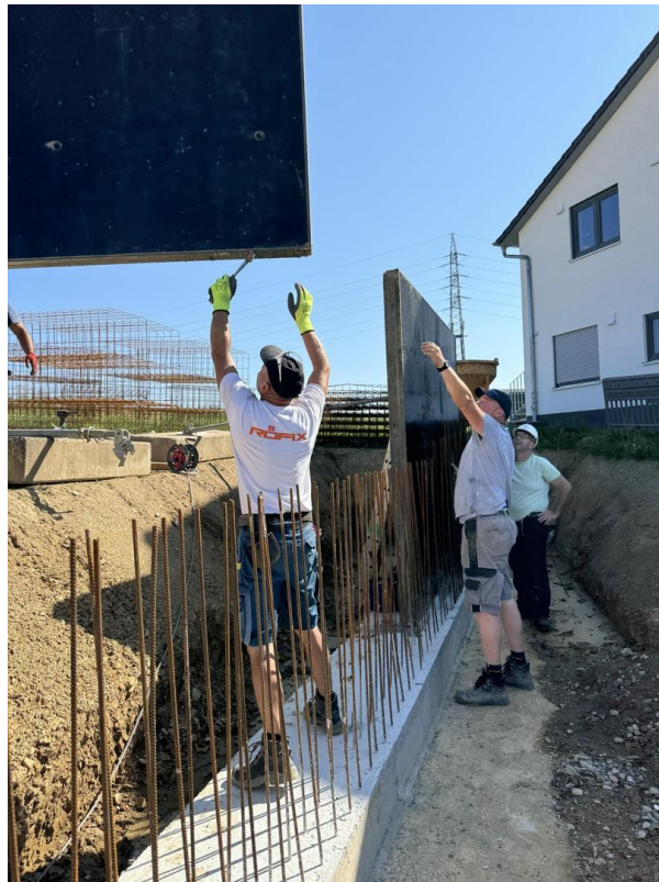
Die Schalung kommt
