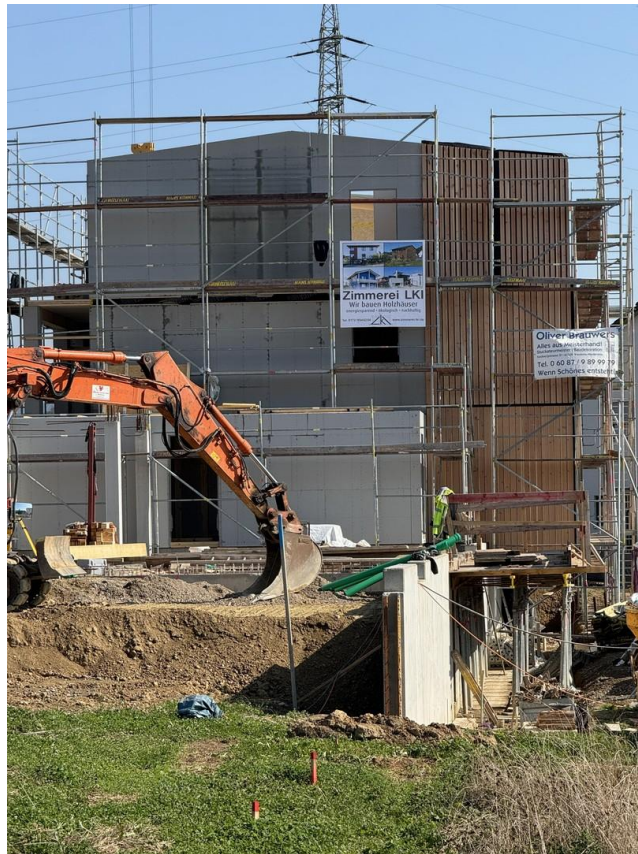
vorne Bagger hinten Haus D
