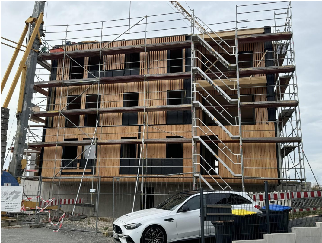
Rohbau Haus D steht
