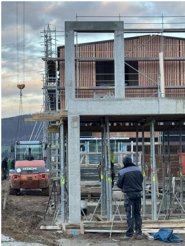
Blick durch den Treppenturm
