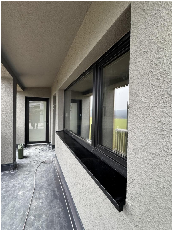
Laubengang ist verputzt
