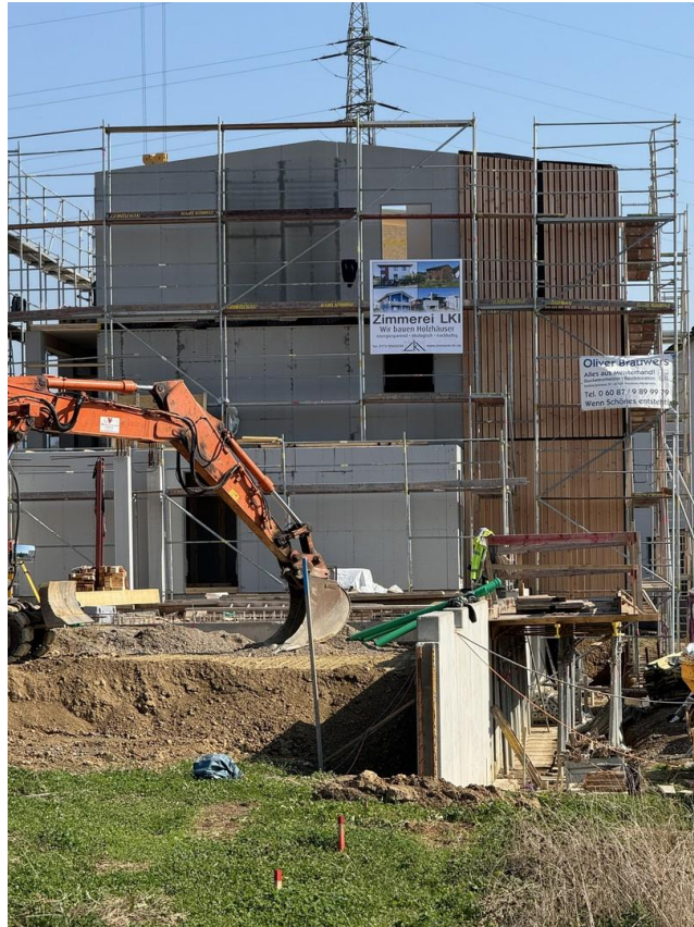
vorne Bagger hinten Haus D
