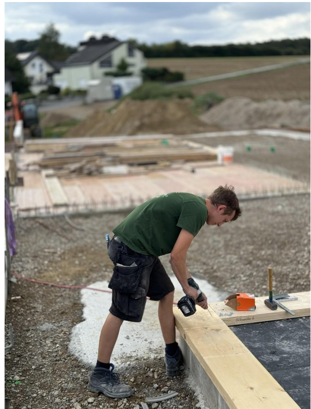
Die Schwellen werden gelegt
