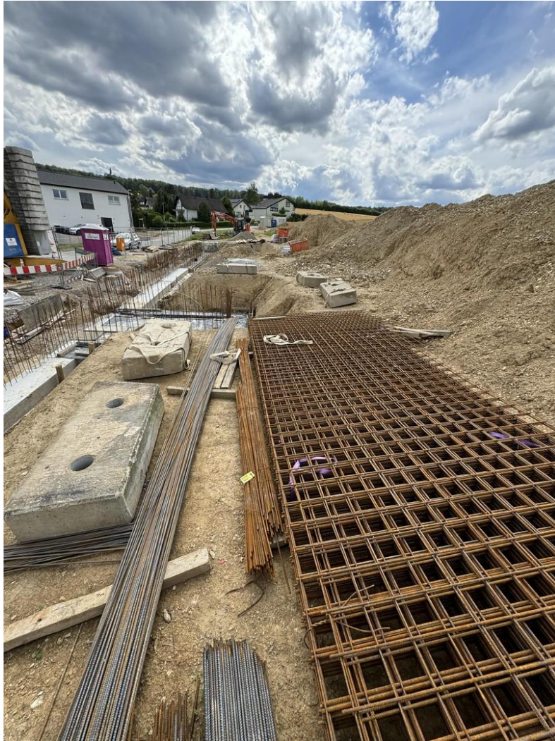
Material am Bau
