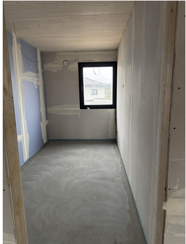
Estrich Haus D ist fertig
