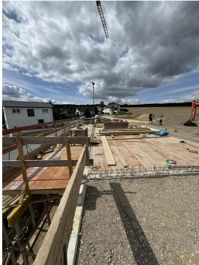
Das wird eine Bodenplatte
