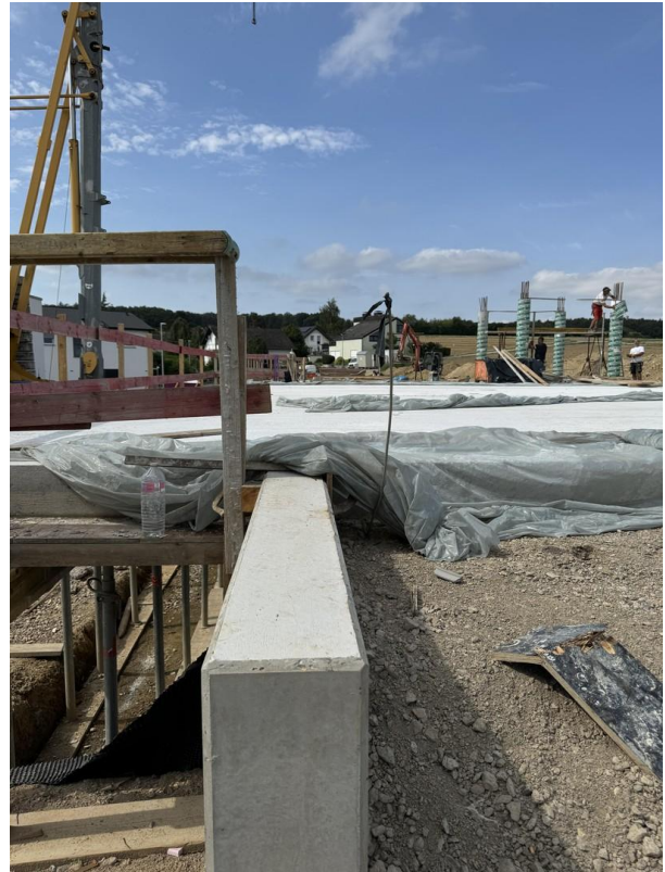
die erste Stützwand steht
