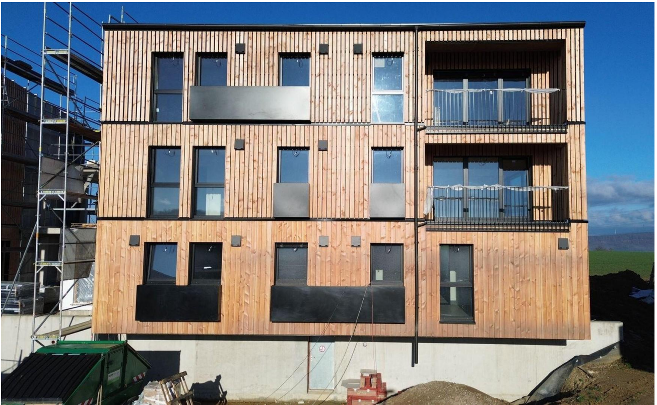
Haus D jetzt ohne Gerüst
